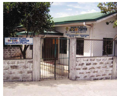
第3番目のデイケアセンター バゴング・シラングセンター (1997年建設)
