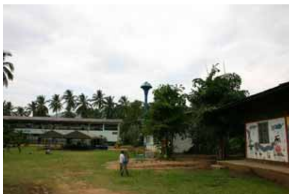
校庭にそびえる15mの給水塔
