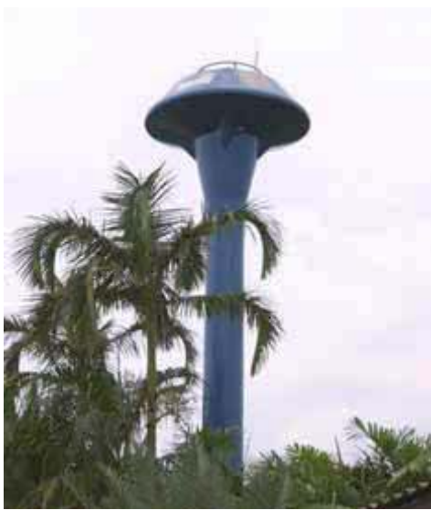
100周年事業の給水塔
